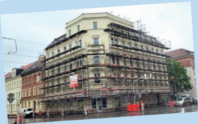
Dach- und Fassadensanierung sowie Erneuerung der Dachflächenfenster in der Antonienstraße 41.
