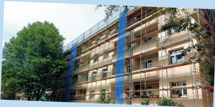
Komplexe Dachsanierung in der Gletschersteinstraße 25-27, der Lausicker Straße 50-60 und der Kommandant-Prendel-Allee 88-90.
