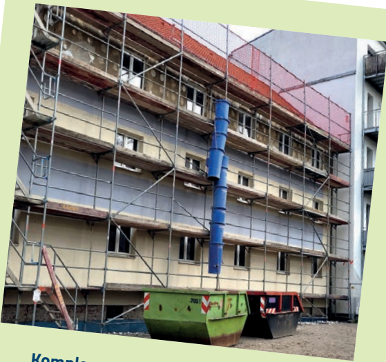
Komplexsanierung Kurze Straße 1-3.
