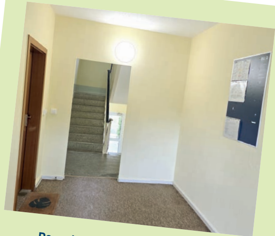
Renovierung der Treppenhäuser im Nelkenweg.
